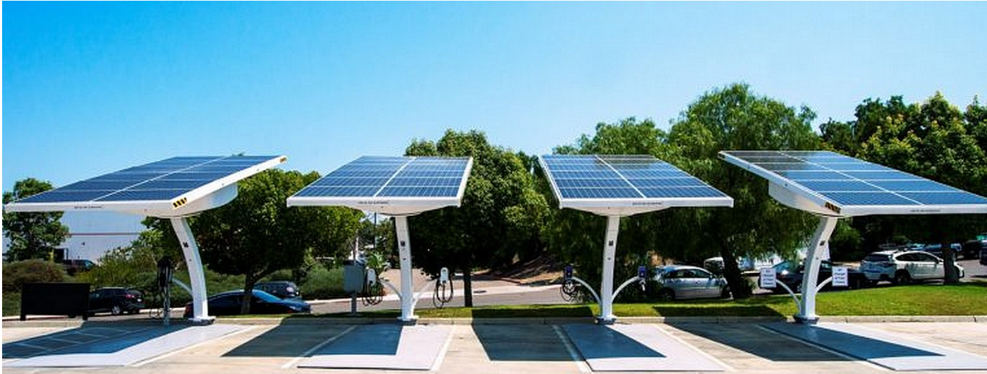
SOLARNA EV KROV
